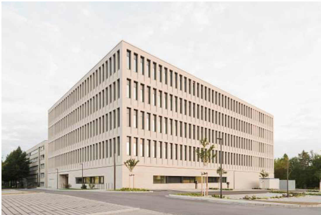
Sieger in der Kategorie „Fassaden und Bauwerke mit massivem Naturstein“: Kriminaltechnisches Institut des LKA Sachsen, Dresden von Architekturbüro heinlewischer, © Brigida González, Stuttgart
