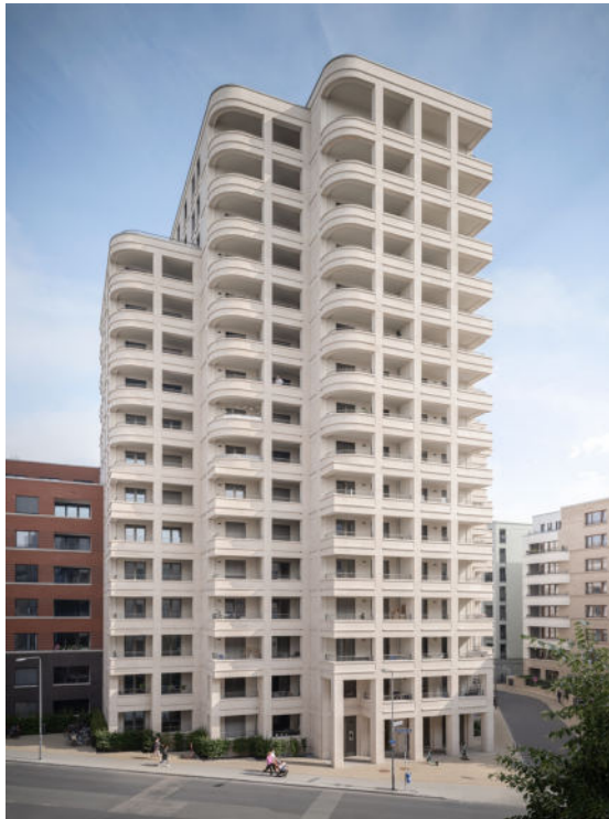
Wohnhochhaus – Drei Horizonte, Frankfurt am Main von O&O Baukunst / ARGE Schwedler Trio, Berlin: Gewinner des Deutschen Naturstein-Preises 2024 & Sieger in der Kategorie „Fassaden mit hinterlüfteten Außenwandbekleidungen aus Naturstein“ © Marcus Bredt, Berlin
