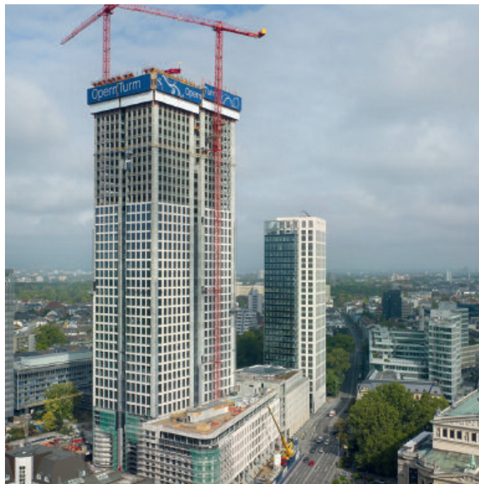
Der Frankfurter OpernTurm in der Bauphase.
